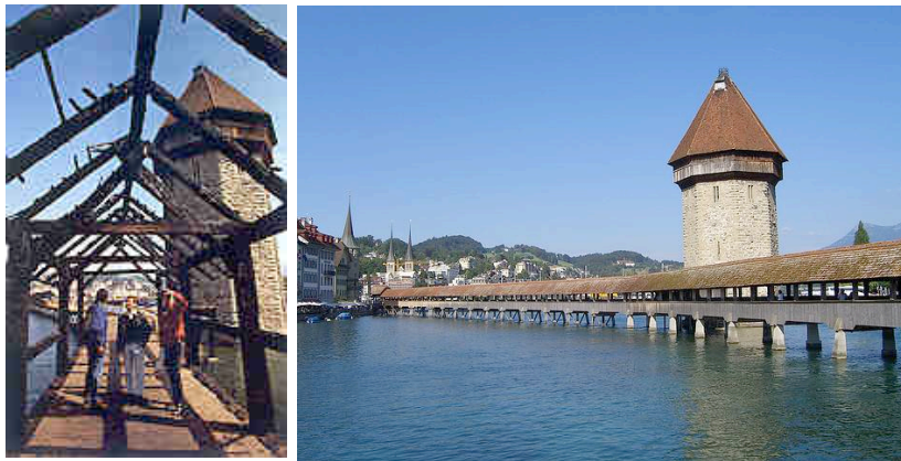
Figura 2. Izquierda: Puerta Capel Bruecke – Lucerna - tras el incendio. Derecha: Puerta Capel Bruecke – Lucerna - restaurada
