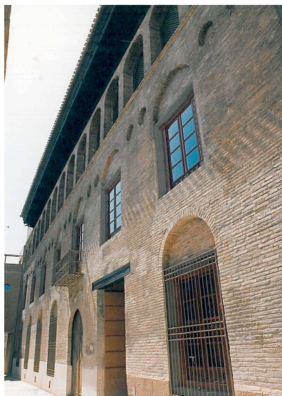
Figura 17. Fachada ya restaurada
