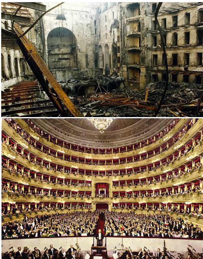
Figura 3. Arriba: Liceo después del incendio. Abajo: Liceo después de la intervención
