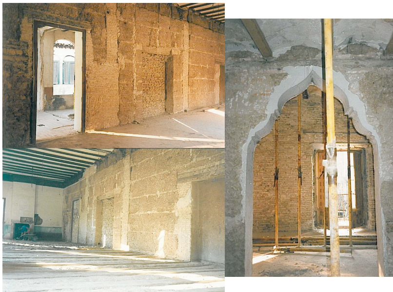
Figura 19. Muros medianeros de tapial
