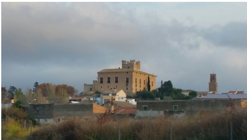
Figura 16. Vista del Castillo-Palacio de los marqueses de San Adrián en Monteagudo, restaurado a mediados del s. XVIII por Francisco Magallón, y a finales del s. XX por José Luis Sanz-Magallón
